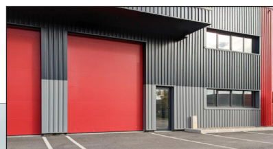
Raccordement électrique de toutes les cellules. Parc sous vidéo surveillance 24 heures sur 24, 7 jours sur 7.
