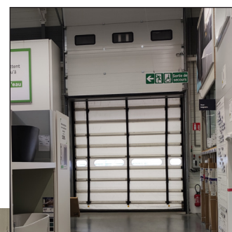
Création d'un nouvel accès logistique depuis la route de Baires.
