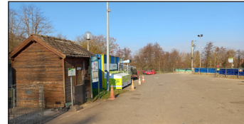
Déchèterie de Benfeld en l'état actuel
