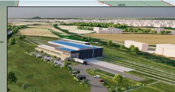
Le bâtiment atelier, intégrant un tour en fosse et traversé par 4 voies ferrées, un faisceau de voies ferrées de desserte des ateliers ainsi qu'une voie de contournement et des voies de stockage du matériel roulant.
