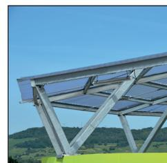
La structure qui couvre la rampe est couverte de plaques translucides reposant sur une ossature métallique. Cette structure est dimensionnée pour accueillir au dernier niveau des panneaux photovoltaïques et leurs ossatures porteuses.
