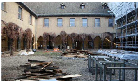
Le cloître du XIII e siècle est en train d'être restauré. Il est classé monument historique.
