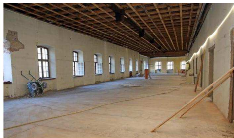
Un escalier sera ajouté dans la grande salle du haut qui abritera la réserve précieuse.
