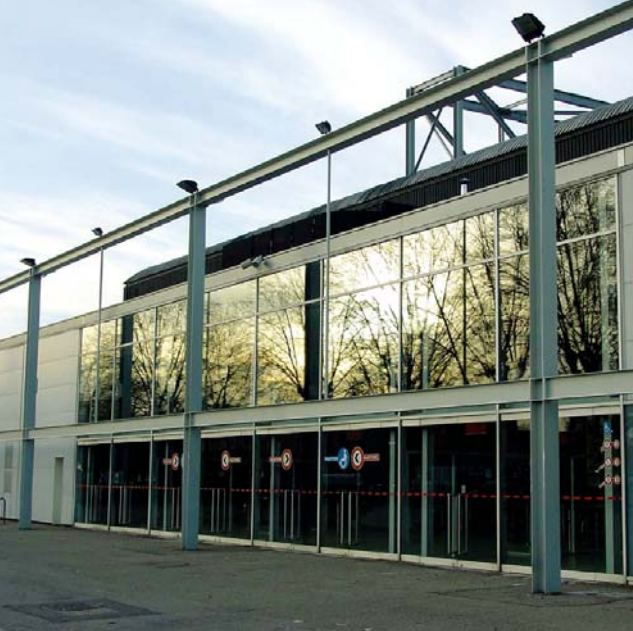
L'ossature métallique a été profondément remaniée
