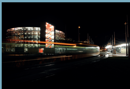
Parking P + relais Tram « Rotonde » à Strasbourg. Architecte : Meyzaud architectes
