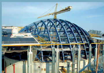
Parlement Européen : SERUE Ingénierie a pris en charge le calcul de la structure de la coupole de l'hémicycle IPE IV.
